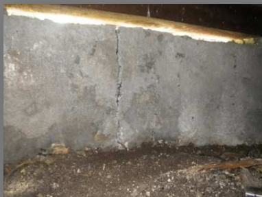
施工前の状態
