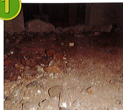
床下整地前 床下の状況を調査します。
